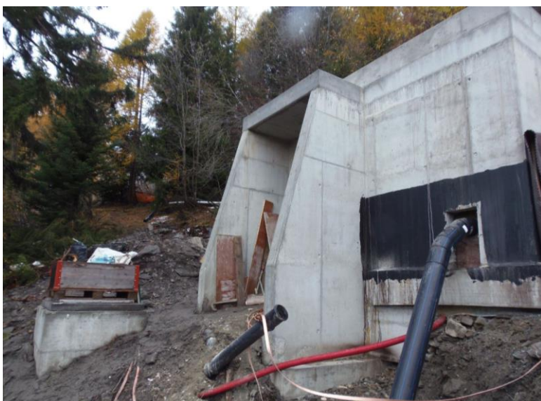
Construction de la chambre coupe pression du Jorat - novembre 2022
