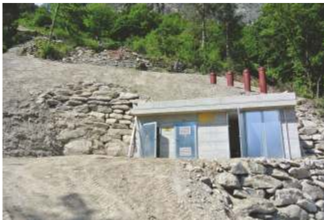
Vue extérieure du local de turbinage
