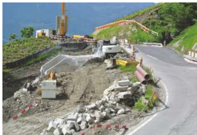
Réfection du pont des « Afforêts »
