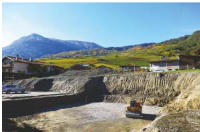
Début des travaux de l'EMS
