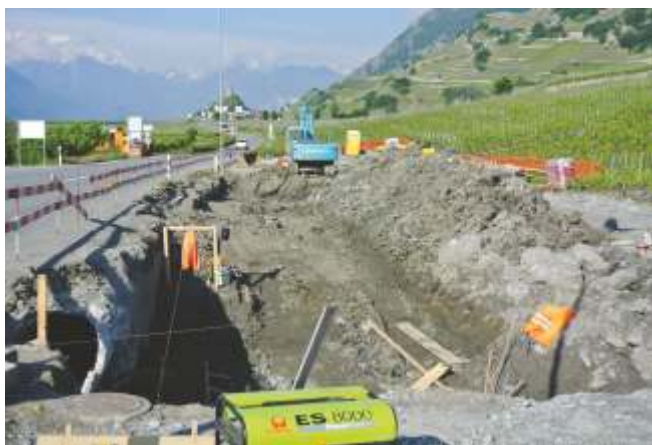
Travaux de correction, secteur « Maladaire »
