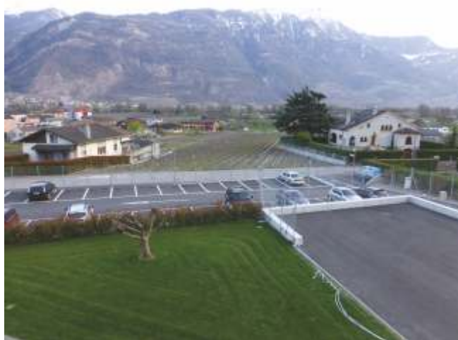
Réfection des cours des écoles
