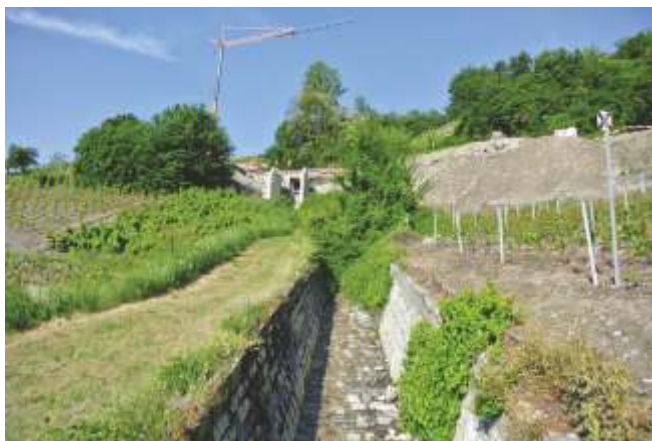
Travaux de correction, secteur « Afforêts »
