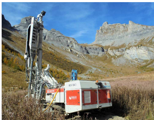
Recherches d'eau potable à Saille
