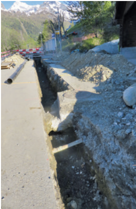
Modification conduite principale d'eau potable
