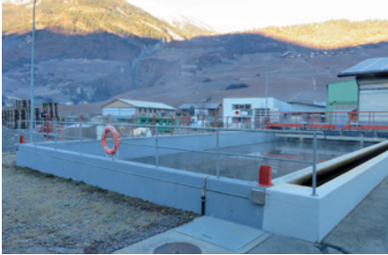
STEP, réfection bassin décantation secondaire
