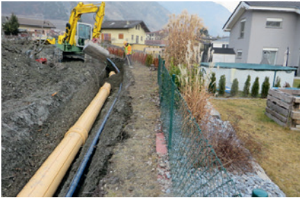
Mise en séparatif du réseau d'eaux usées
