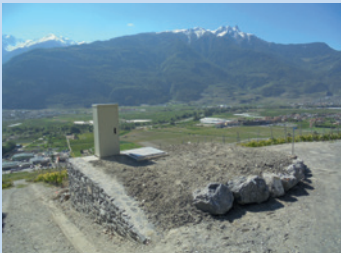
Chambre d'eau potable de Produit
