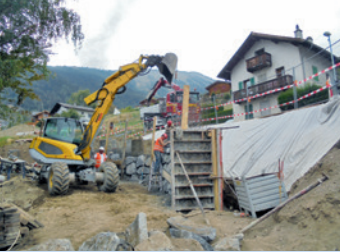
Travaux RC 70 Dugny
