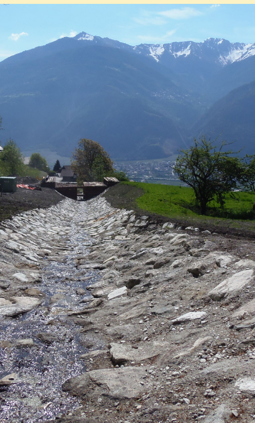
Vue en amont du nouveau dépotoir du Salenday ^ avec le nouveau tracé du torrent de la Seya
